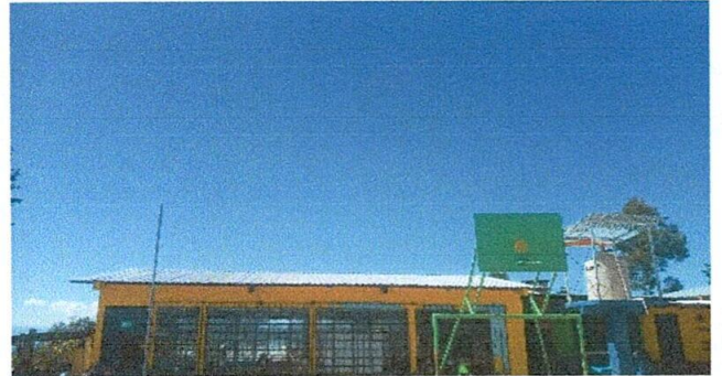
Foto 4: Sustitución de Techo Aluzinc
