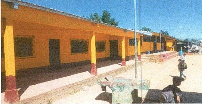
Foto1: Cambio de pintura
